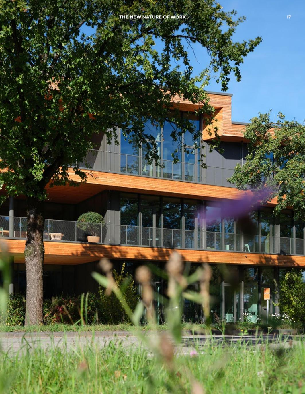
WOODS steht für echten **Holzbau**, keine Holz/Beton-Hybridkonstruktion: Alle oberirdischen tragenden Bauteile – Decken, Stützen, Träger und das Dach – werden vollständig aus nachhaltigem Holz\* hergestellt. Der Stahlbetonanteil wird auf das notwendige und materialtechnisch sinnvolle Minimum reduziert. Lediglich Treppenhauskerne, Aufzugschächte und Parkgaragen werden aus Stahlbeton gefertigt – ein auf die Materialeigenschaften hin optimierter, ganzheitlicher Ansatz.
